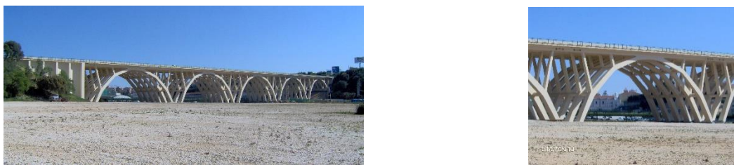
Figura 8.11 - Viaduto sobre o rio Trancão (Sacavém) [48]
