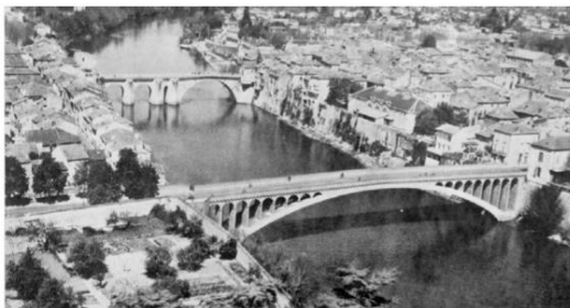
Figura 1.2 - Ponte Villeneuve-Sur-Lot de Freyssinet, 1919 [1]
