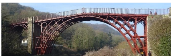
Figura 2.7 - Ponte de Coalbrookdale, Inglaterra [2]
